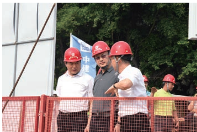
▲ 集团领导检查在建项目
