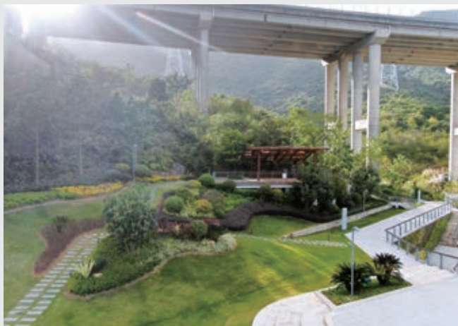
▲ 坝光国际生物谷观景平台
