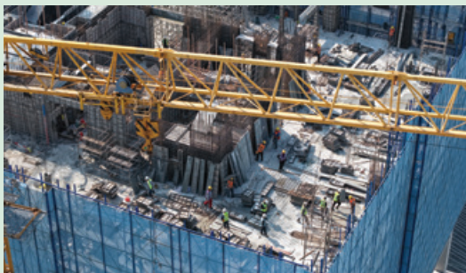
● 无人机巡检银盈大厦施工
