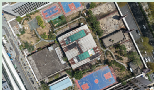
● 无人机巡检笋岗车城施工
