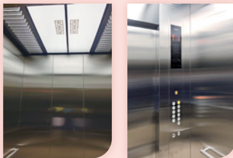
老旧电梯更换
