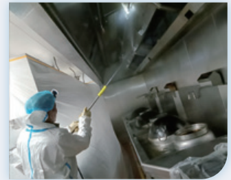
商管公司排烟管道改造
