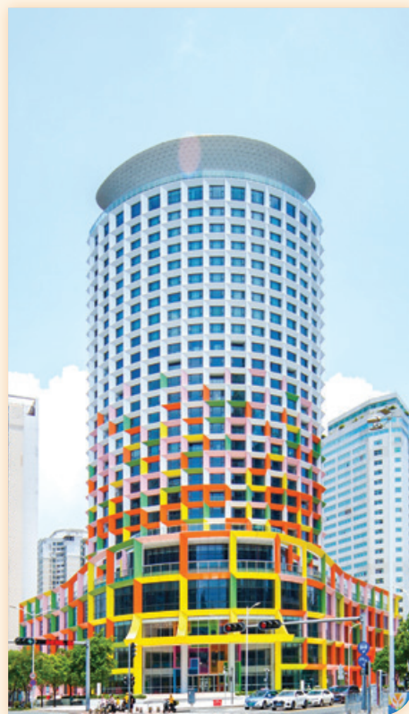
深圳妇儿大厦项目
