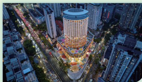
深圳妇儿大厦项目
