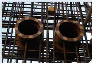
三段式止水套管的“柔性防水套管”安装现场
