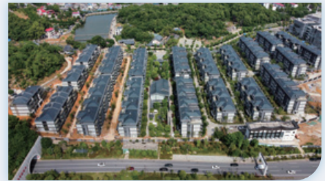
鹏南公司光伏泛光照明项目
